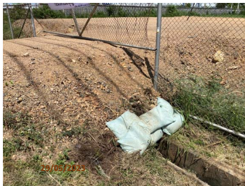
รูปที่ 10 ก้นดินหรือวางกระสอบทรายป้องกันการชะของตะกอนดิน
